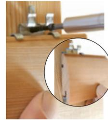
Den Clip an der Unterkonstruktion fixieren
