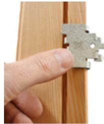
Montageclip positionieren und mit leichtem Druck einfügen
